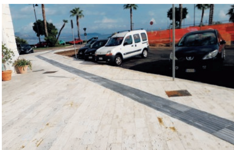
I lavori in corso sul lungomare
