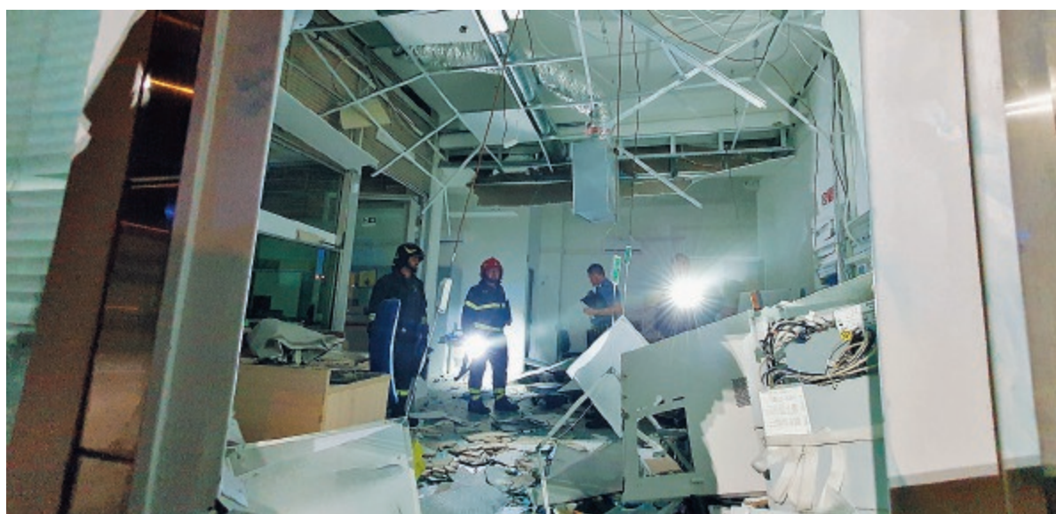
L'ufficio postale devastato visto dall'esterno attraverso il buco rimasto dopo l'esplosione dello sportello automatico
