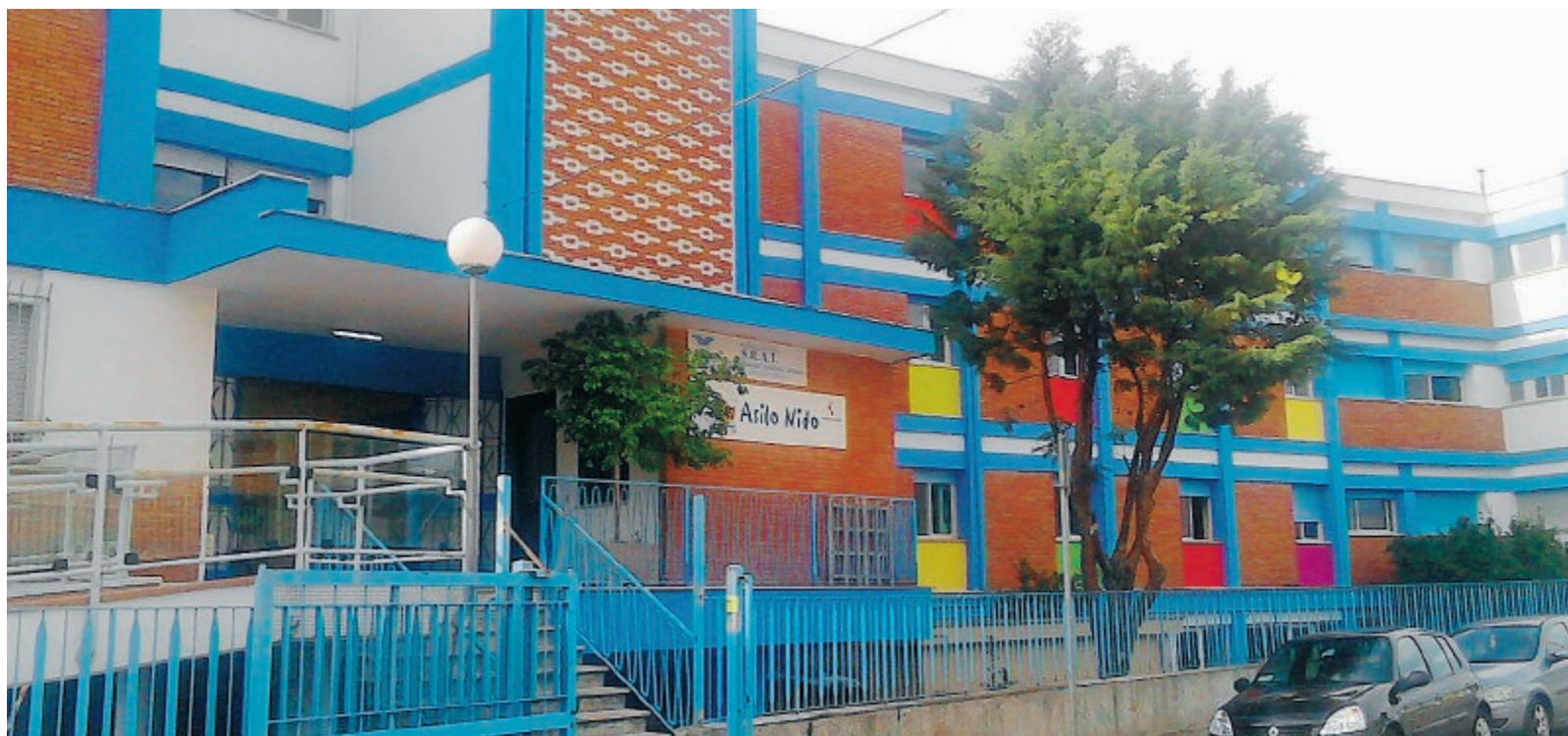
I locali di Via Amalfi dove è stato realizzato l'ostello del Golfo
