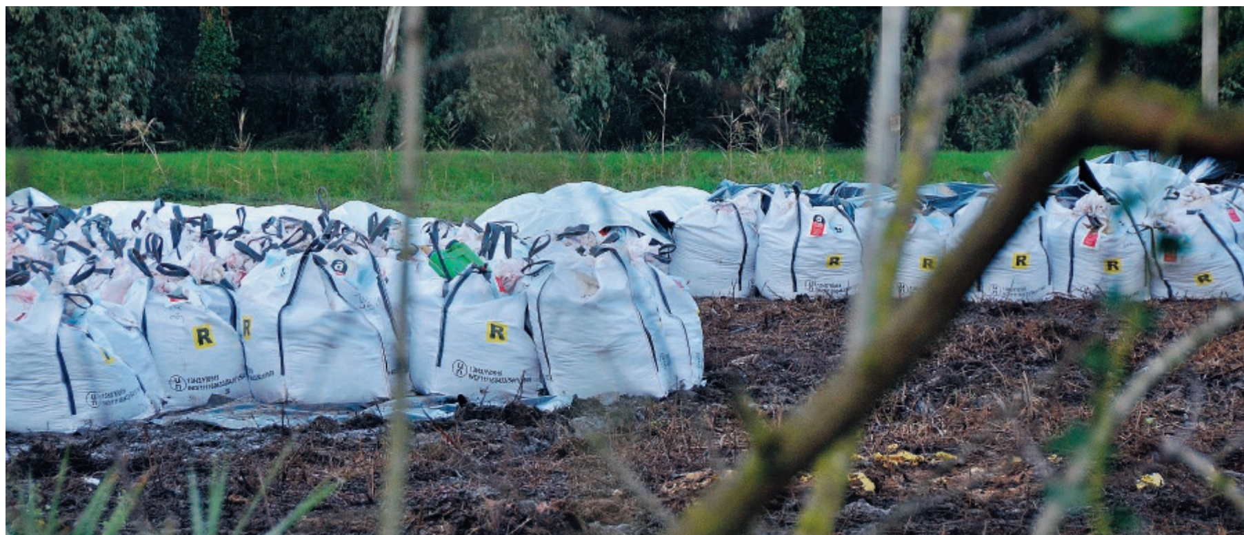
In foto al lato i sacchi utilizzati per rimuovere terra e rifiuti durante la campagna di scavi avviata da Sogin per valutare le dimensioni dell'area interessata dagli interrimenti
