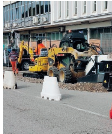
Un cantiere di Acqualatina
