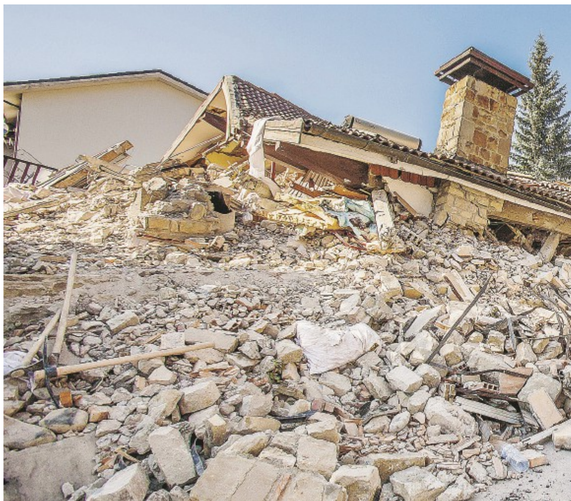
Alcune immagini dei danni causati dal terremoto del 24 agosto di un anno fa
