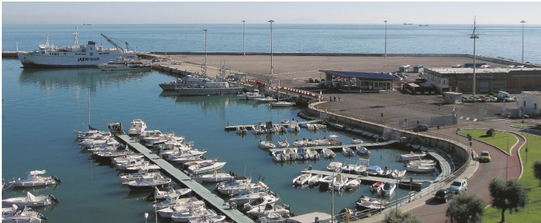
A sinistra il molo Vespucci dove è prevista l'installazione dei quattro impianti di dissalazione
