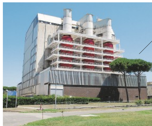
La centrale di Borgo Sabotino
