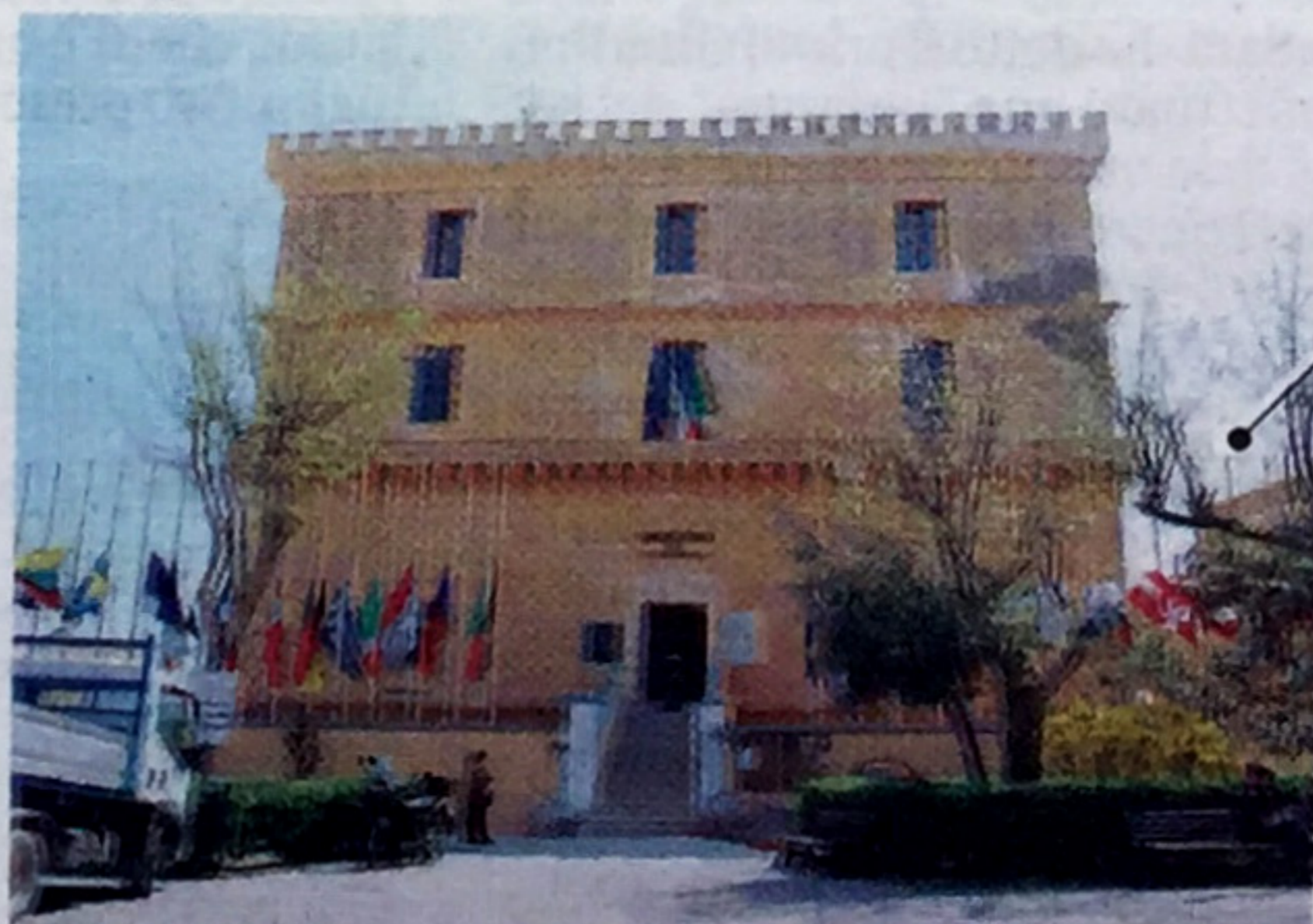
Nella foto a sinistra il palazzo comunale di Ventotene
