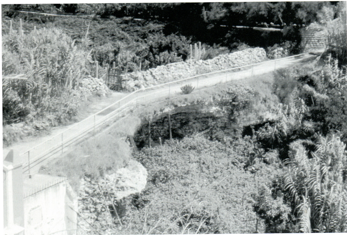
Fig. 2 - Giancos (Ponza). Veduta dall'alto della diga, con l'invaso colmatato.
