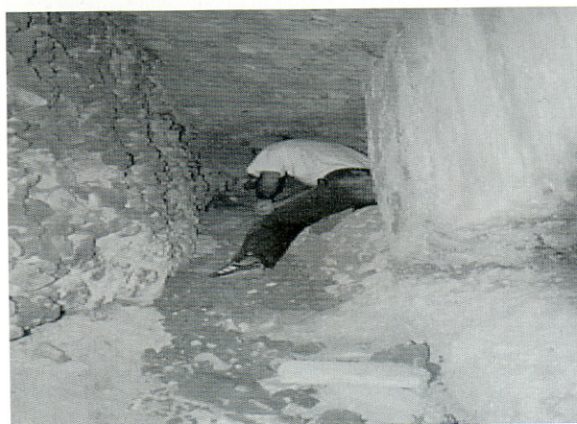
Fig. 3 - Giancos (Ponza). Galleria interna alla diga.
