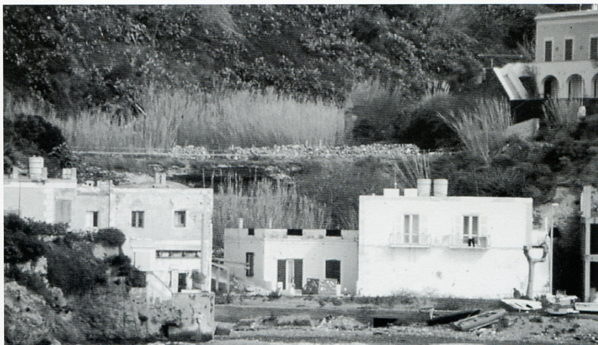
Fig. 1 - Giancos (Ponza). La diga vista dal mare.
