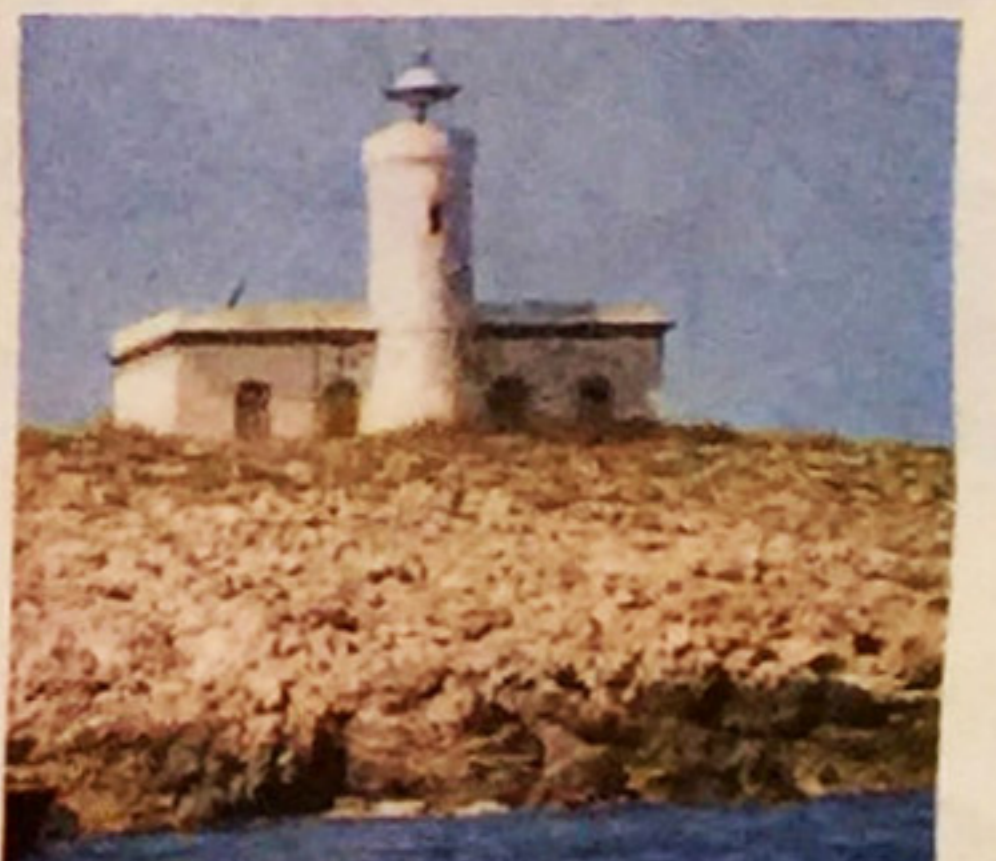
FORMICHE (GROSSETO) Sul più grande dei tre isolotti compresi nell'arcipelago toscano, il faro venne attivato dalla Regia Marina nel 1901 proprio per illuminare gli isolotti
