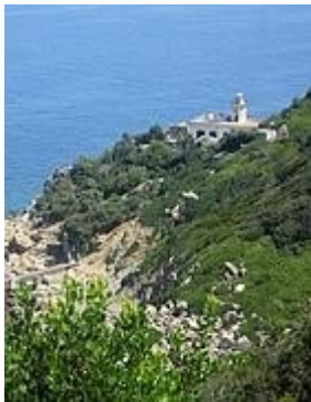
Vista sul faro di Zannone (Marangon)
