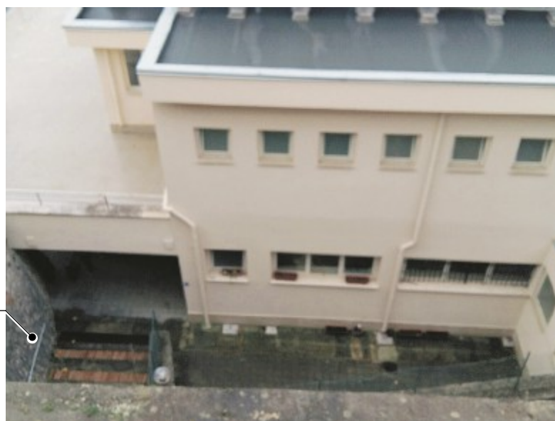
La scuola elementare della frazione di Maranola
