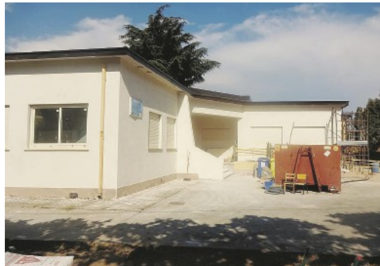
I lavori alla scuola dell'infanzia Giovanni Paolo II
